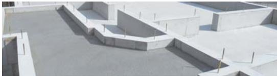
建物全体の重量を支え、地震などの外力を地盤に分散させる基礎。強度と耐久性に優れた鉄筋コンクリート造の「ベタ基礎」を採用しています。
